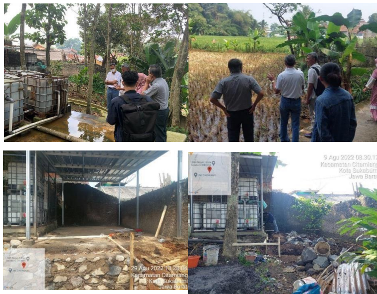
Gambar 1. Survey dan Pembangunan IPAL
