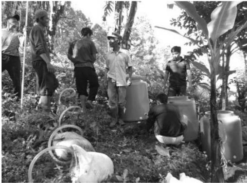
**Gambar 4. Pemasangan instalasi air bersih**
