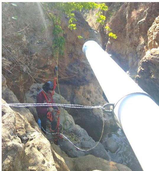
**Gambar 4. Pemasangan instalasi air bersih**
