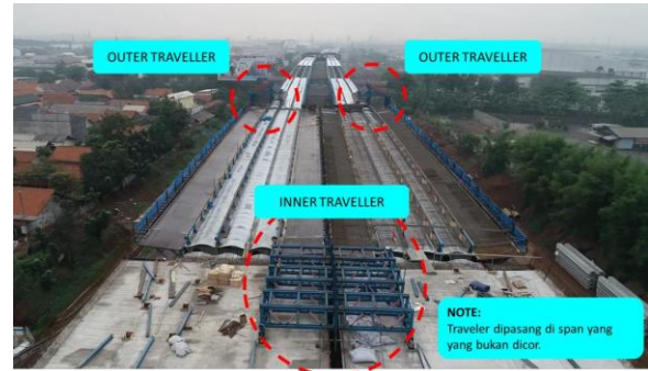
Gambar 3. Penggunaan traveler sistem pada pengecoran slab.
