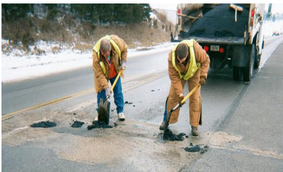
Gambar 11 Perbaikan sementara Sumber : Asphalt Potholes repair
